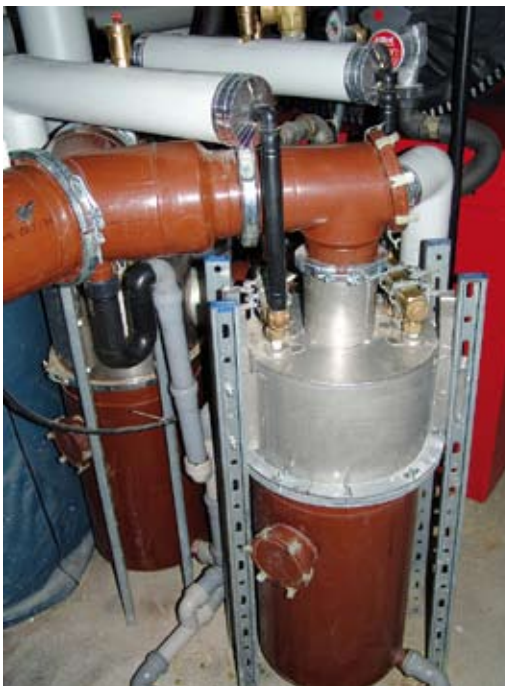
Zwei TechnaPlus-Wärmetauscher hinter dem neuen Ölkessel
